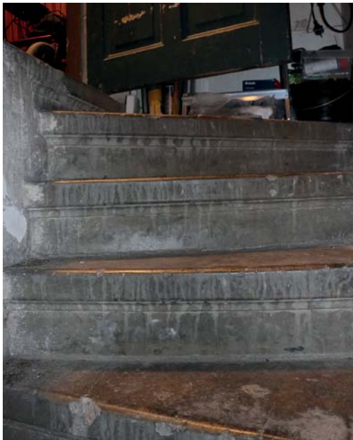
Källartrappa i natursten med fina detaljer i trappstegen och ursprunglig inredning i källare. Förråd som tidigare fungerat som matkällare.
