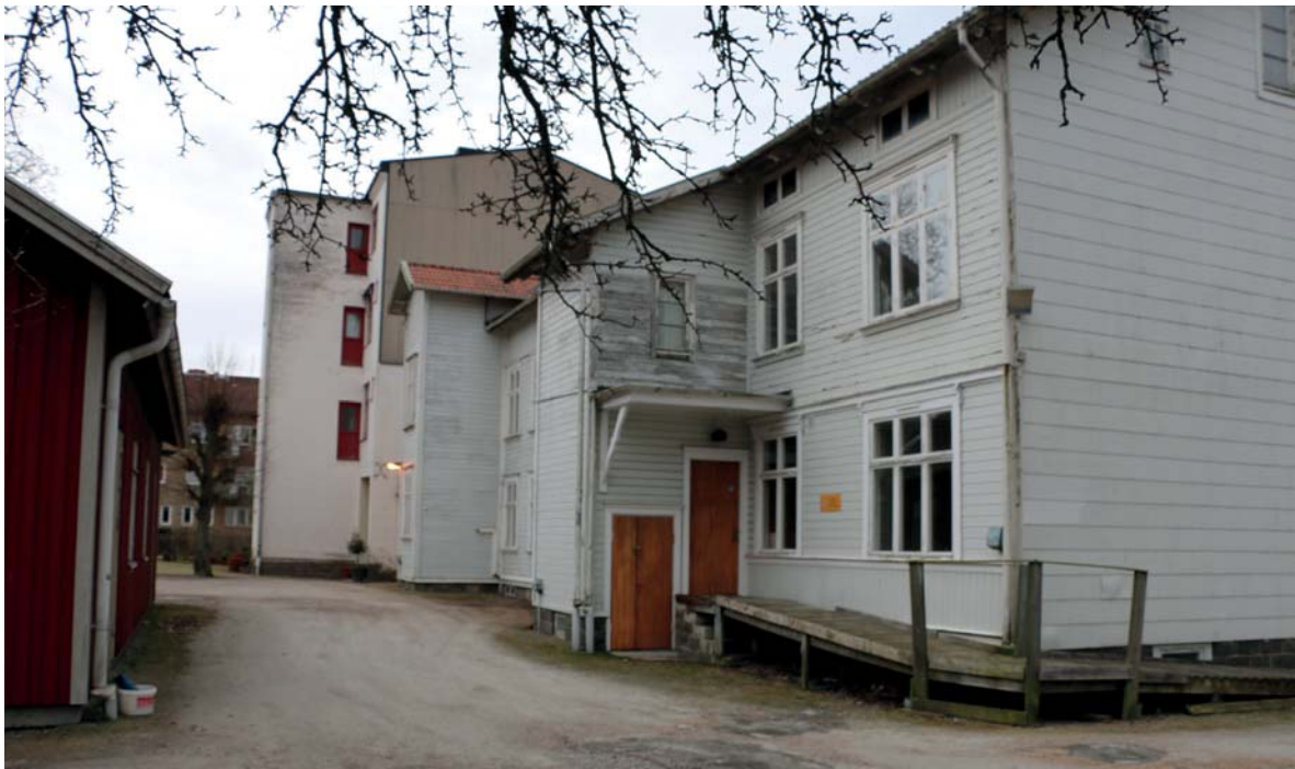
Trapphus mot gården. Eternitklädd gavelfasad.
