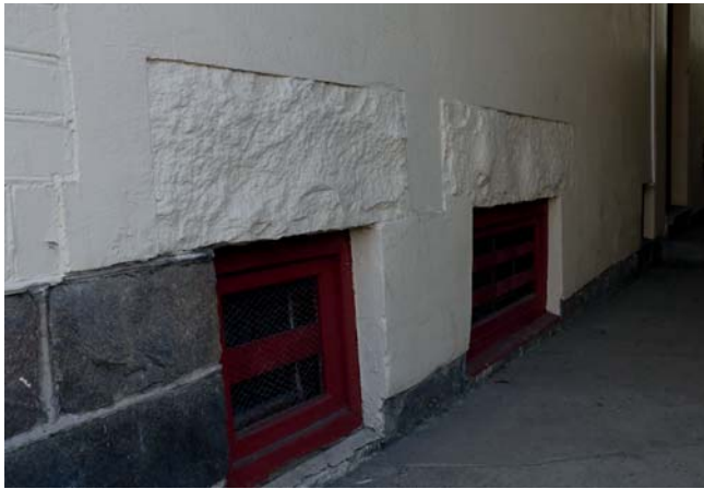
Grund av natursten och murade fasader av kalksandsten med rundfog.
