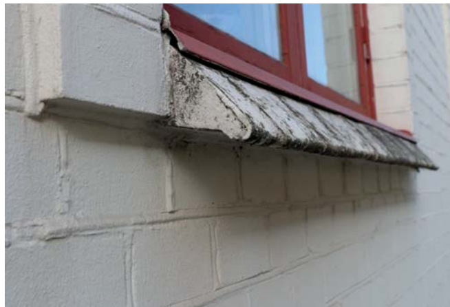
Grund av natursten och murade fasader av kalksandsten med rundfog.
