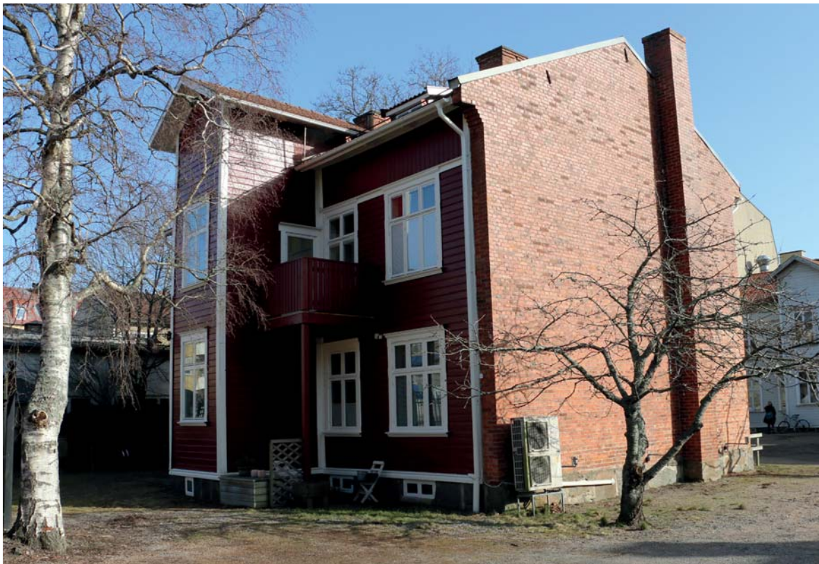
Brandmur i tegel. Trapphus mot baksidan och senare tillkommen balkong.
