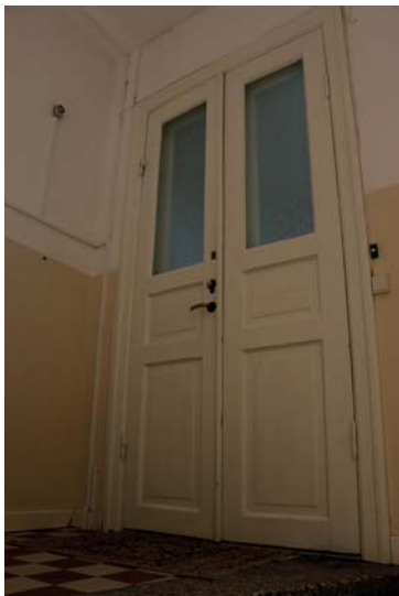
Pardörr i trä och glas, ursprungliga klinkerplattor i trapphusen.
