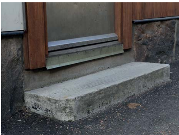
Entrétrappa i kalksten och eternitklädda fasader mot gatan.
