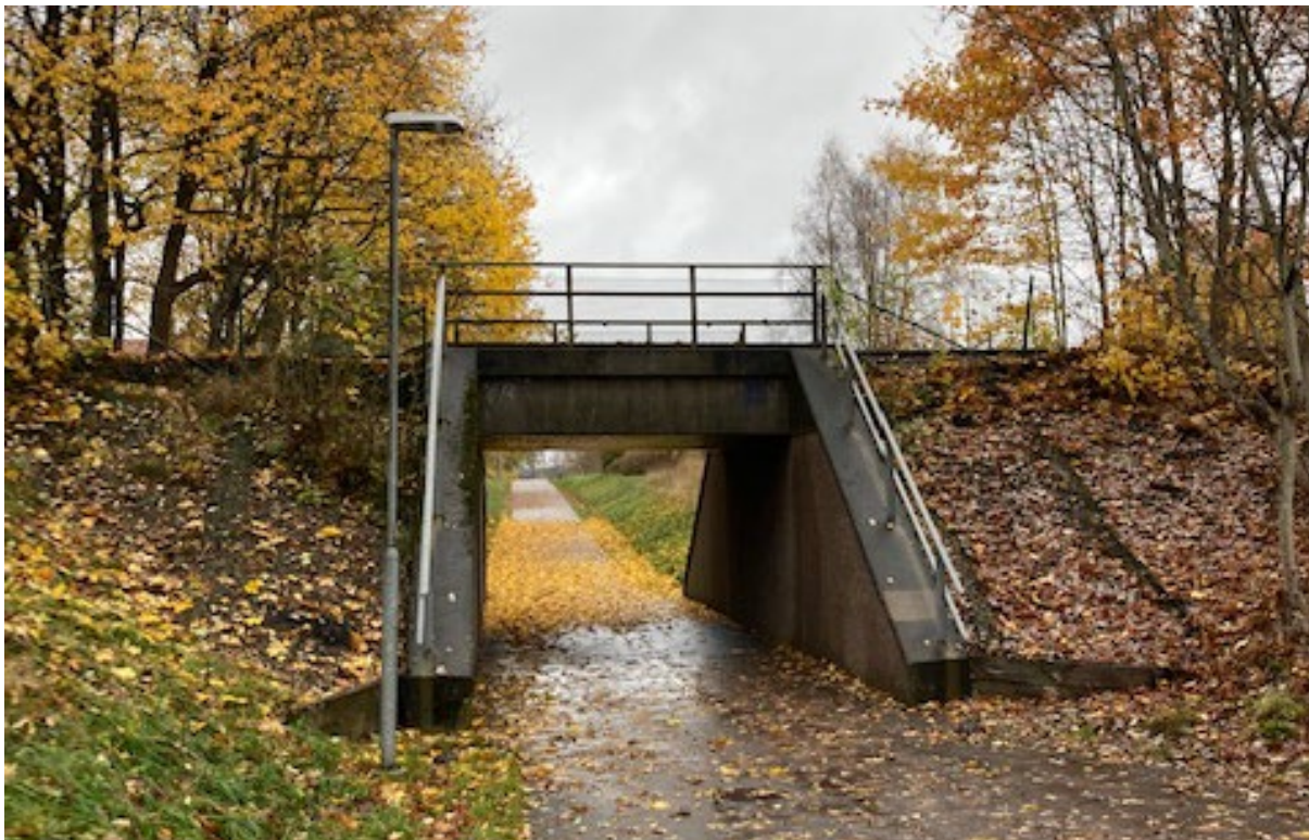
Figur 9. Gång- och cykeltunnel under järnväg (Bildkälla: Platsbesök 211028)
