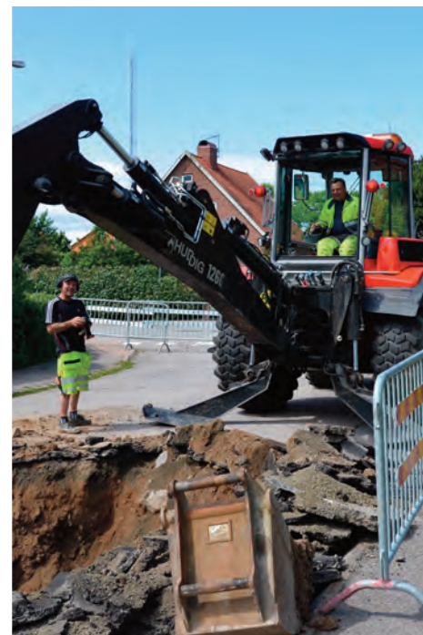
Gatukontoret gräver på Gyllenheimsgatan. Foto: Gun-Britt Karlsson
