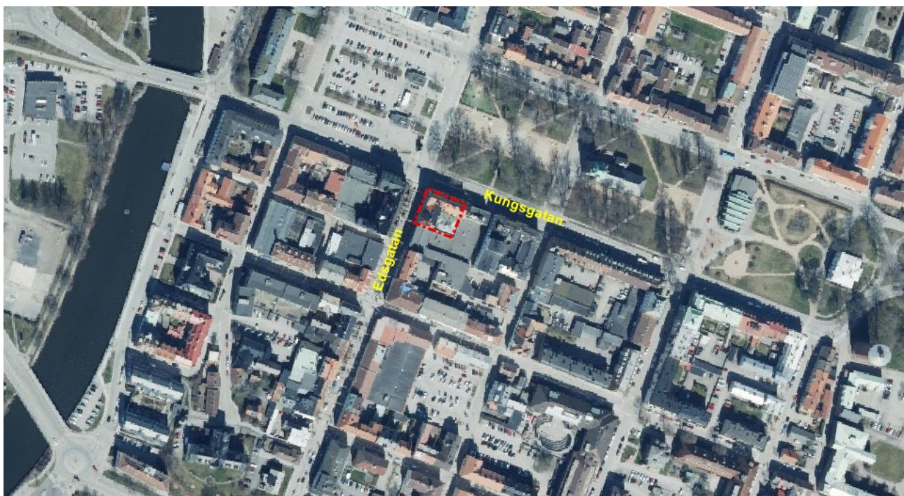
Fastighetens läge i Vänersborg.
